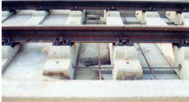
شکل ۱: سیستم خط Rheda
